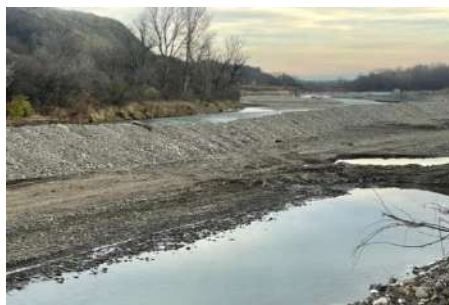
Рисунок 7.1.103 – Проверка хода выполненных работ по капитальному ремонту гидротехнических сооружений
