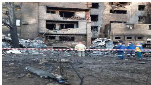
Рисунок 3.4.2 – Разрушение 9-ти этажного дома в г. Ейске в результате крушения самолёта СУ-34 17.10.2022 г.
