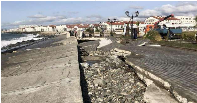
Рисунок 1.3.7 – Воздействие головных частей каньона Мзымты на набережную Имеретинской низменности (Адлер). Последствия шторма 01.12.2021
